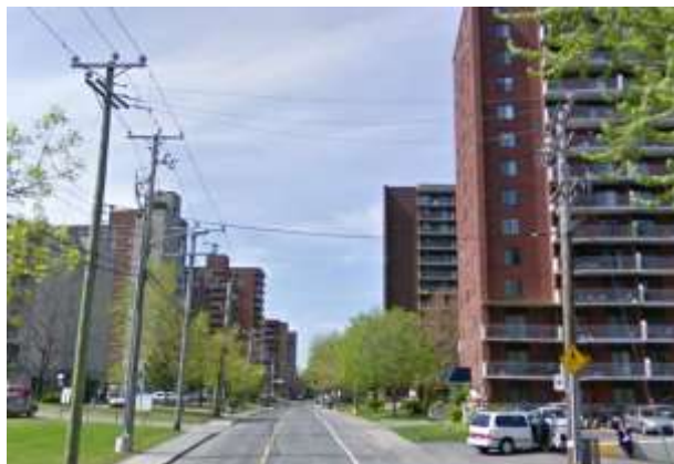
Figure 31 : Édifices à résidences pour personnes âgées à l'est de Montréal.
